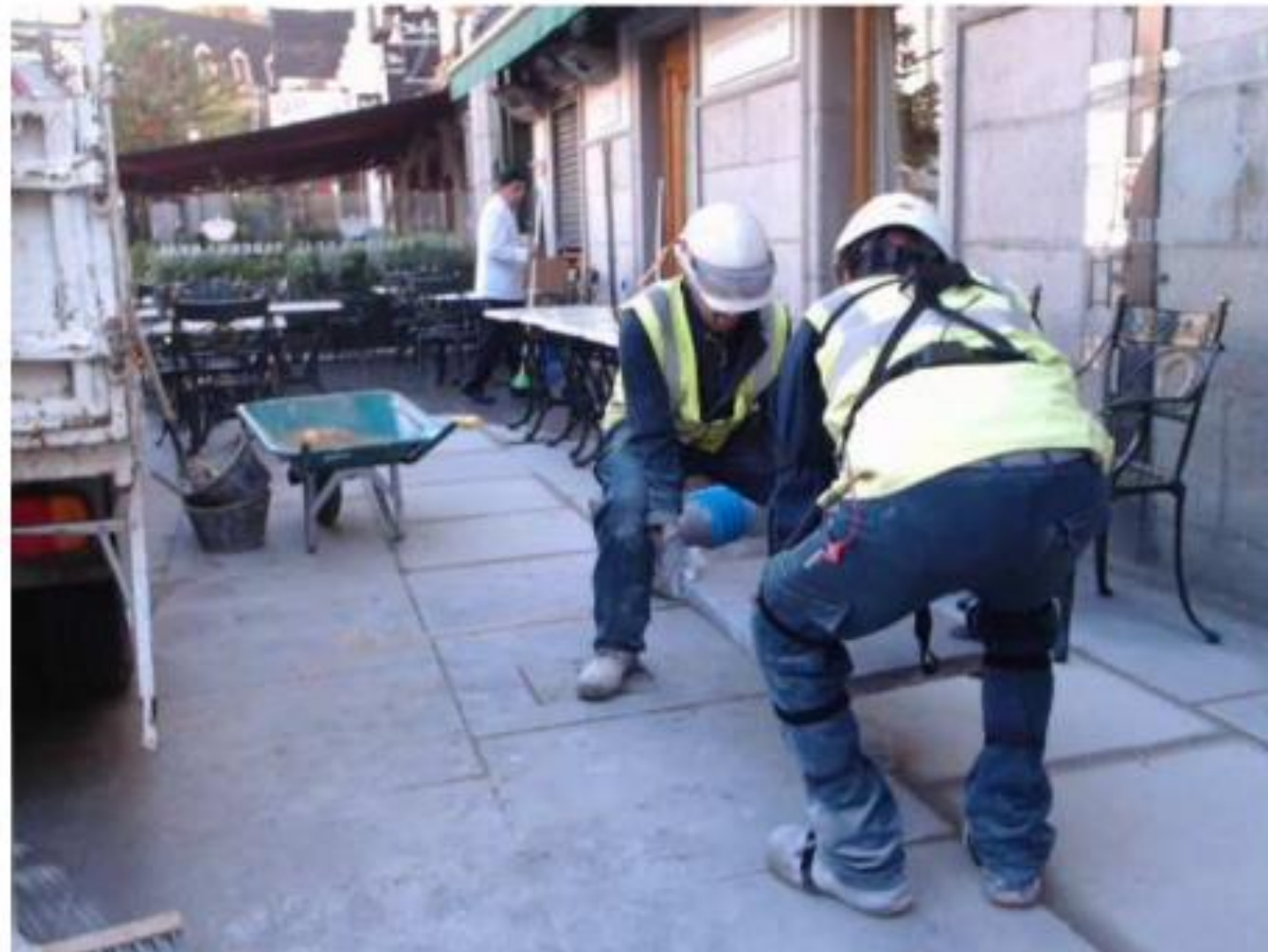
Foto 3. Descarga de loseta grande(37,5 kg).
